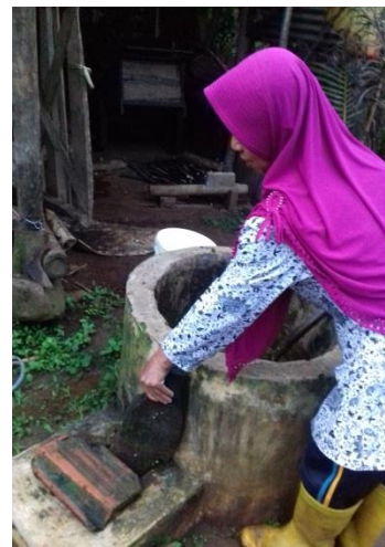
Gambar 6. Memasukkan campuran feses dan air ke dalam digester
